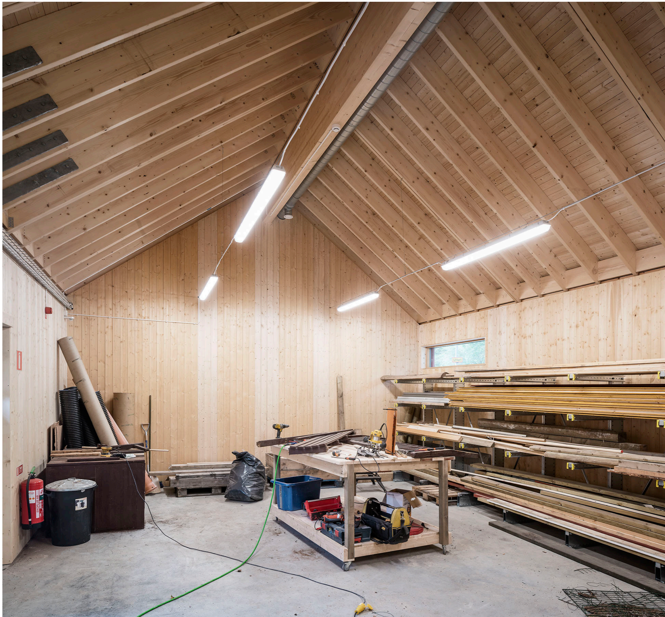
Väggar och tak är beklädda med 120 mm bred finsågad spontad panel som är obehandlad.
