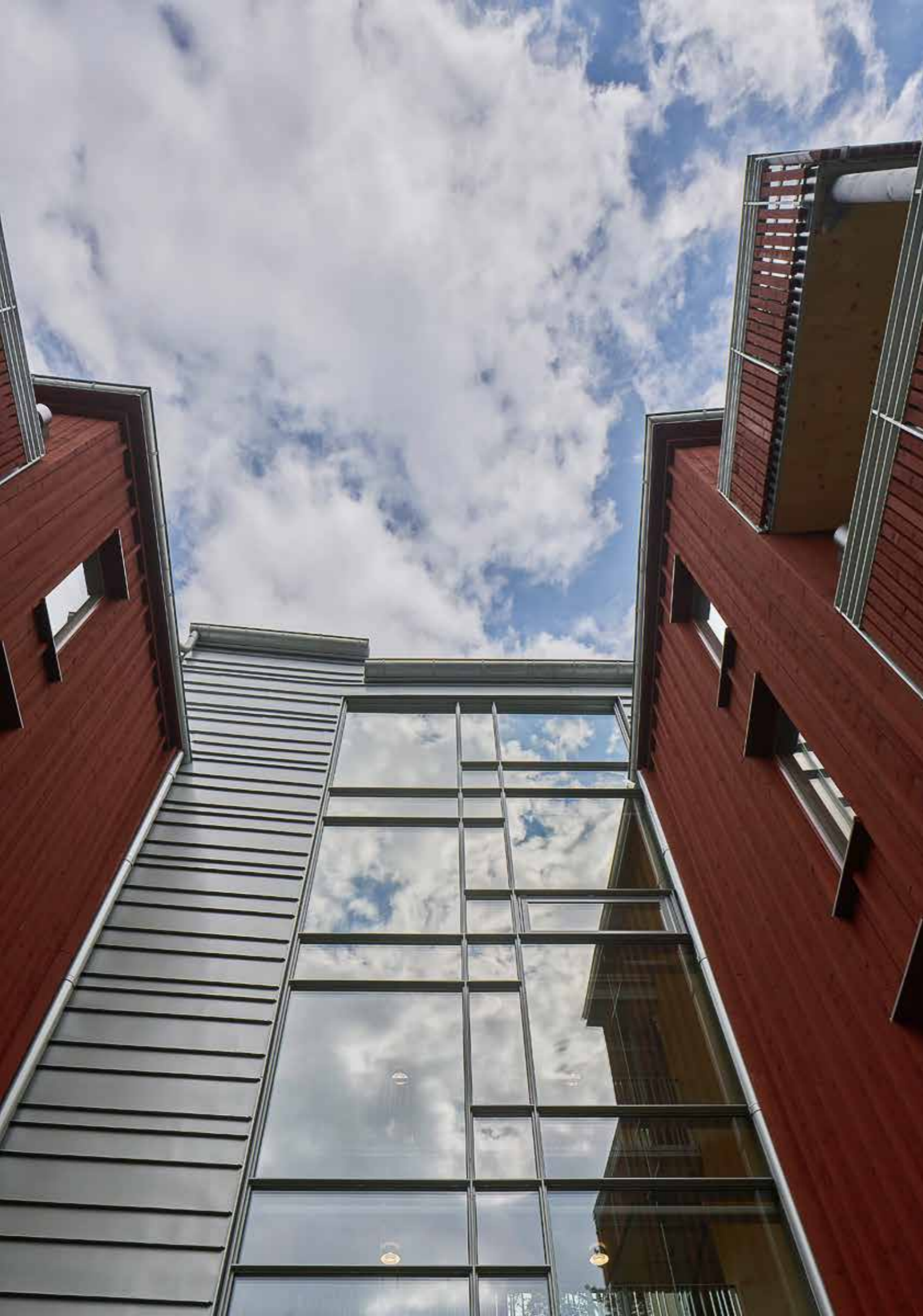
Ett modernt trähus med rötter i den svenska byggnadstraditionen
